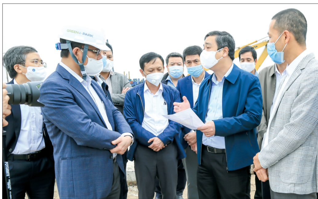
Đồng chí Ngô Đông Hải, Ủy viên Ban Chấp hành Trung ương Đảng, Bí thư Tỉnh ủy kiểm tra tiến độ thi công hạ tầng khu công nghiệp Liên Hà Thái.
