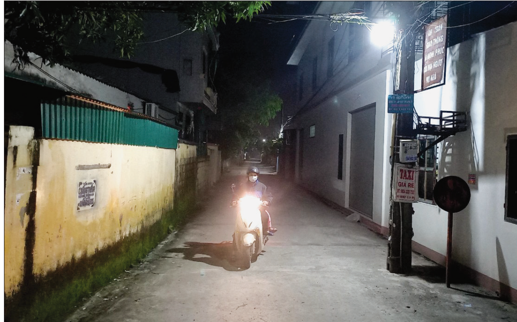
Các tuyến đường giao thông trên địa bàn xã Đông Hòa (thành phố Thái Bình) được lắp đặt đèn điện chiếu sáng thuận lợi trong sinh hoạt, giao thông và phát triển kinh tế của người dân.
