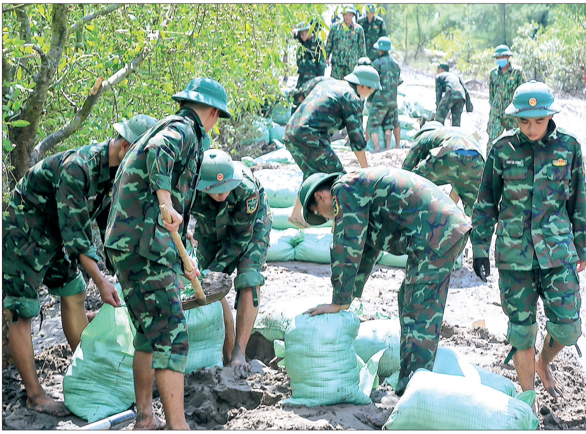
Thi công các hạng mục công trình phục vụ diễn tập.
