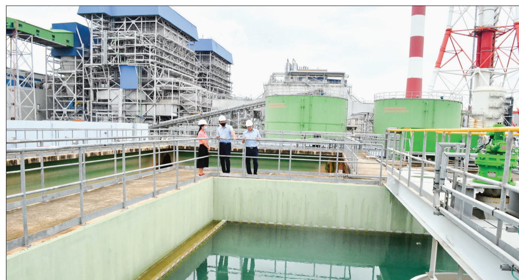
Khu xử lý nước thải tập trung của nhà máy.
