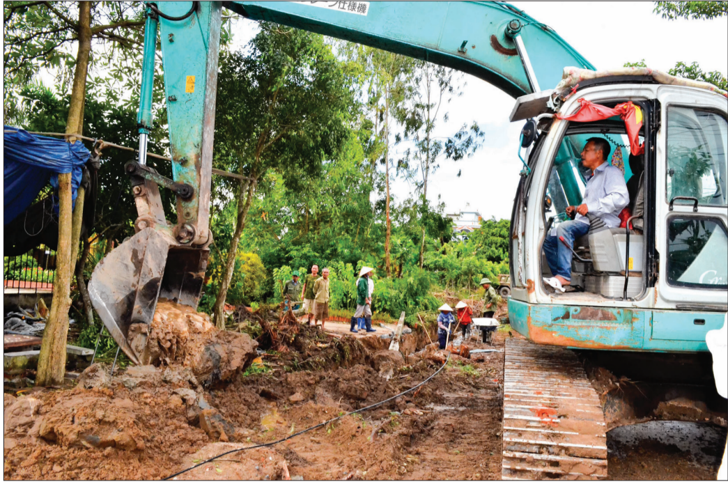
Người dân xã Lô Giang (Đồng Hưng) tích cực bàn giao mặt bằng để thi công đường ĐH45.
