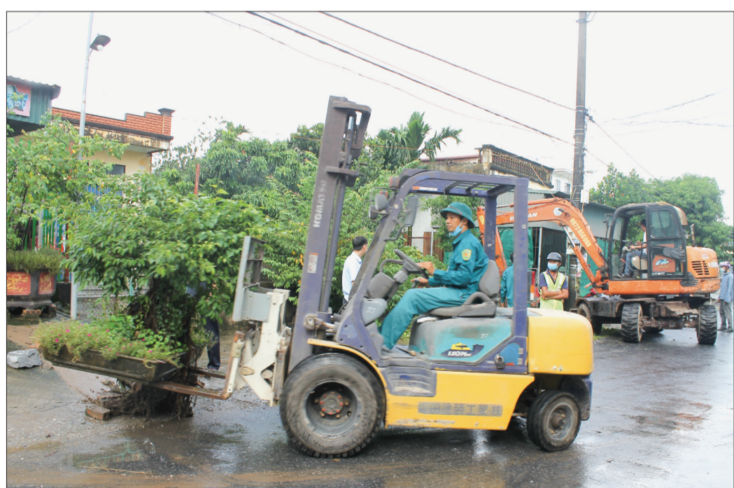
Nhờ sự đồng thuận của hầu hết các hộ dân, đến nay công tác giải phóng mặt bằng dự án đường ĐH.13 đã cơ bản hoàn thành.
