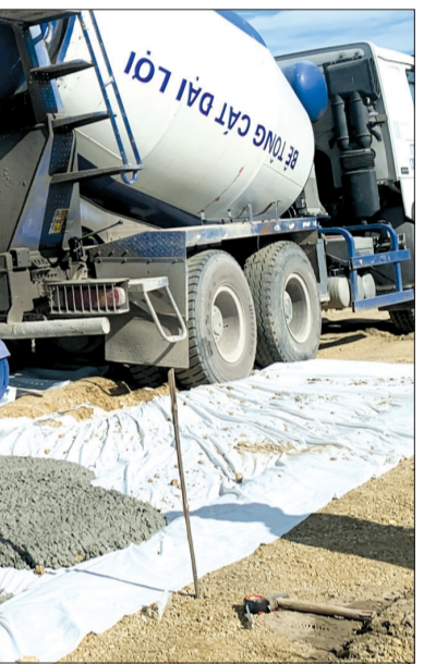
Thi công tuyến đường vành đai phía Nam thành phố Thái Bình, đoạn từ cầu gang S1 đến đường Chu Văn An kéo dài.
