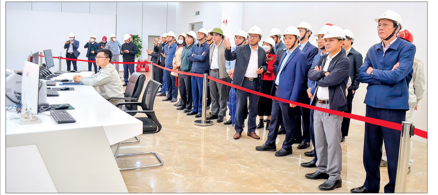
Các đồng chí lãnh đạo tỉnh và đại biểu thăm khu điều hành của nhà máy điện rác Sóc Sơn, thành phố Hà Nội.
