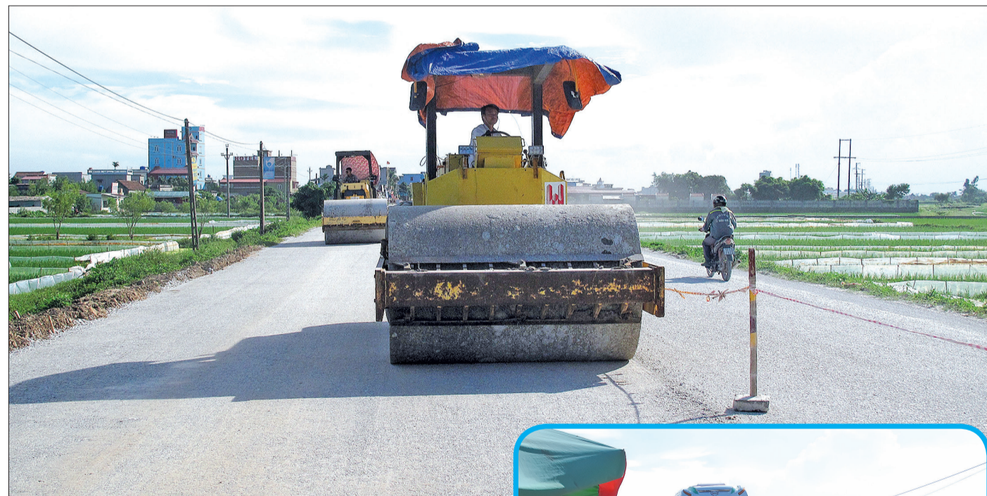
Thi công tuyến đường tỉnh 456.
