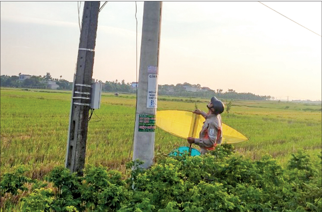
Công nhân Công ty Điện lực Thái Bình xử lý sự cố do diều vướng vào đường dây điện.
