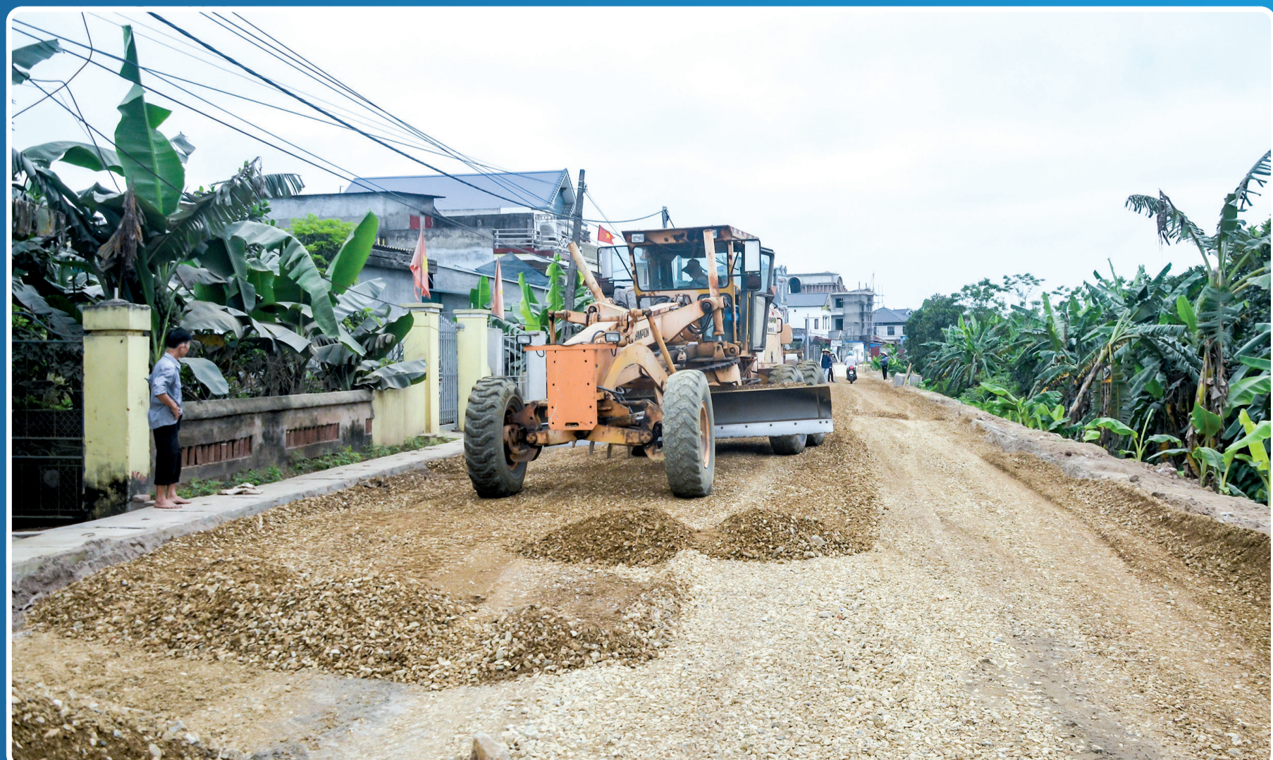
Tuyến đường tỉnh ĐT.452 qua xã Quỳnh Ngọc (Quỳnh Phụ) đang được các đơn vị thi công gấp rút triển khai để bảo đảm tiến độ.
