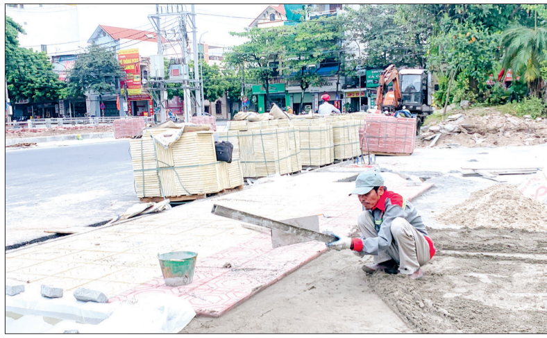
Thi công hoàn thiện vỉa hè đường Ngô Quyền.
