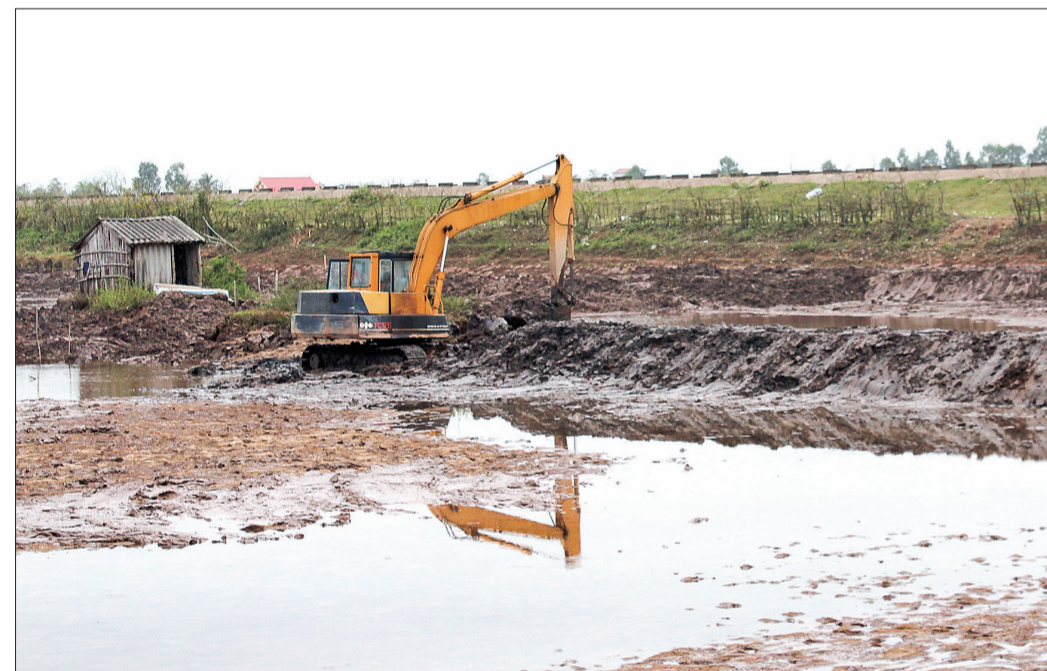
Hộ nuôi trồng thủy sản huyện Thái Thụy gia cố bờ chuẩn bị nuôi thả tôm.
