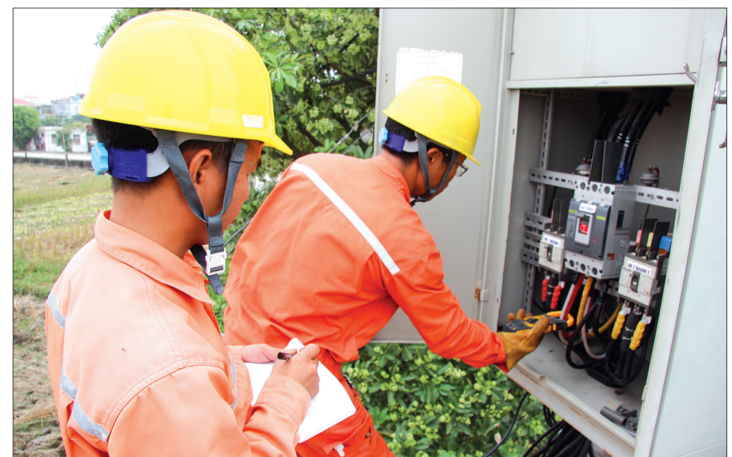
Công nhân ngành điện kiểm tra hệ thống bảo đảm cung cấp điện an toàn.
