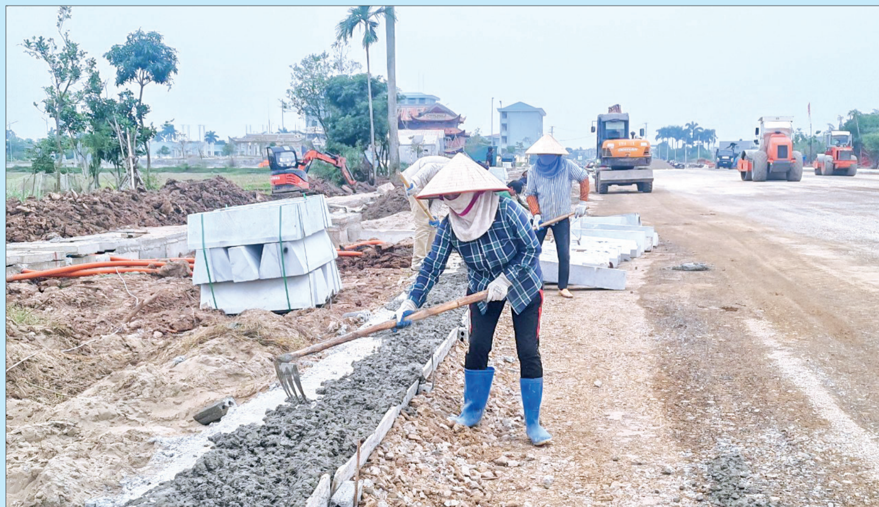
Tuyến đường quy hoạch số 2, khu đô thị Hoàng Diệu (thành phố Thái Bình) đang được gấp rút hoàn thành.
