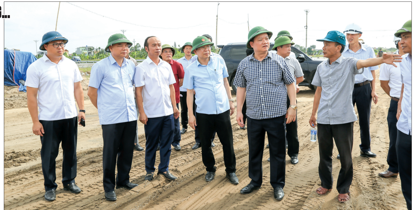
Đồng chí Nguyễn Khắc Thân, Phó Bí thư Tỉnh ủy, Chủ tịch UBND tỉnh kiểm tra công tác quản lý, đầu tư và tiến độ phát triển hạ tầng cụm công nghiệp Thống Nhất (Hưng Hà). Ảnh: MINH ĐỨC
