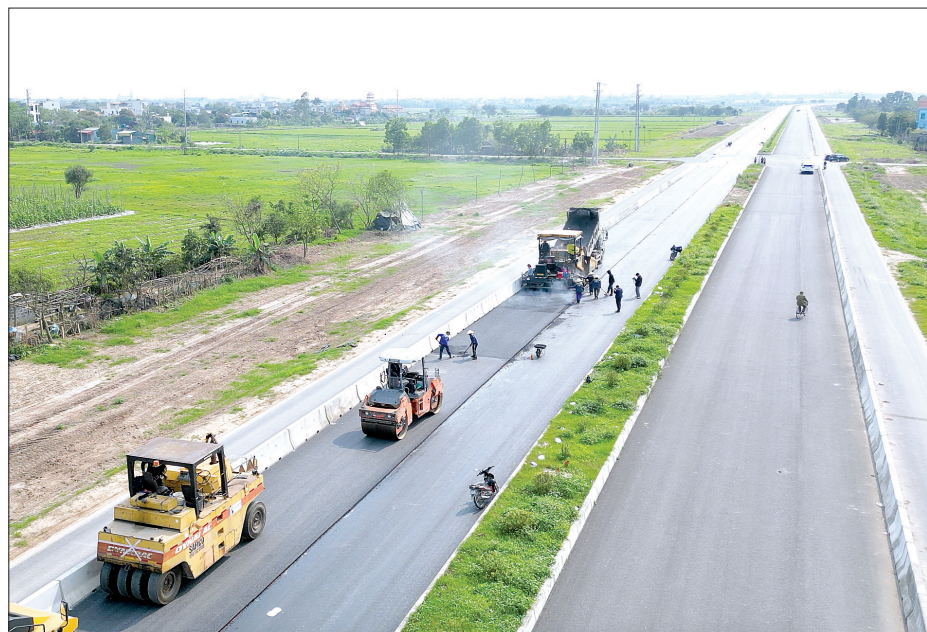
Đơn vị thi công thảm bê tông nhựa C12.5 đoạn từ nút giao với đường tỉnh ĐT.463 đến cầu Kiến Giang tại nút giao đường Chu Văn An kéo dài.
