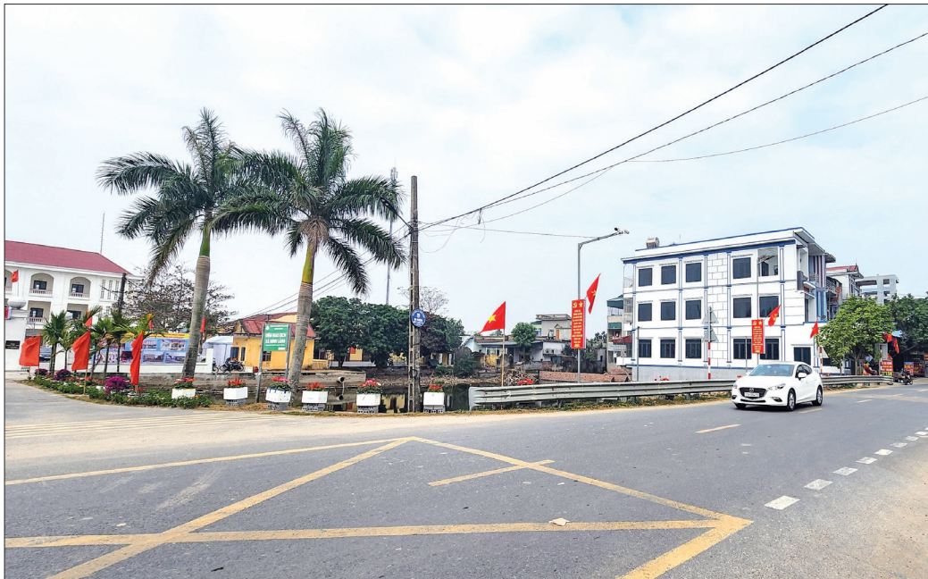
Hạ tầng giao thông xã Minh Lăng (Vũ Thư) được đầu tư đồng bộ.
