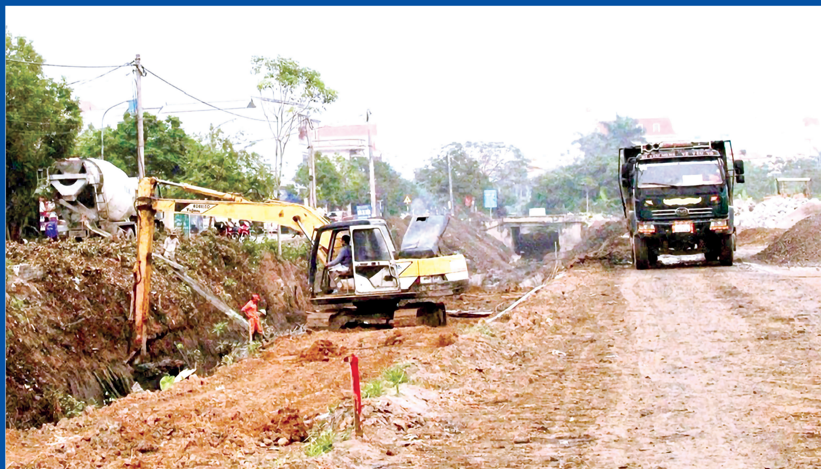
Công ty TNHH Đầu tư và xây dựng Thủy Sơn huy động nhân lực, phương tiện đẩy nhanh tiến độ thi công dự án hạ tầng kỹ thuật khu dân cư Phúc Lộc, thị trấn Hưng Hà (Hưng Hà).
