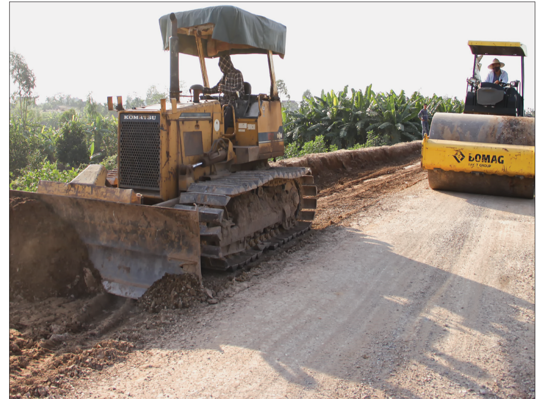
Công ty Cổ phần Đông Đô - Thái Bình thi công đê tả Hồng Hà, đoạn từ K150 - K152+800 qua địa phận xã Đông Thanh (Vũ Thư).
