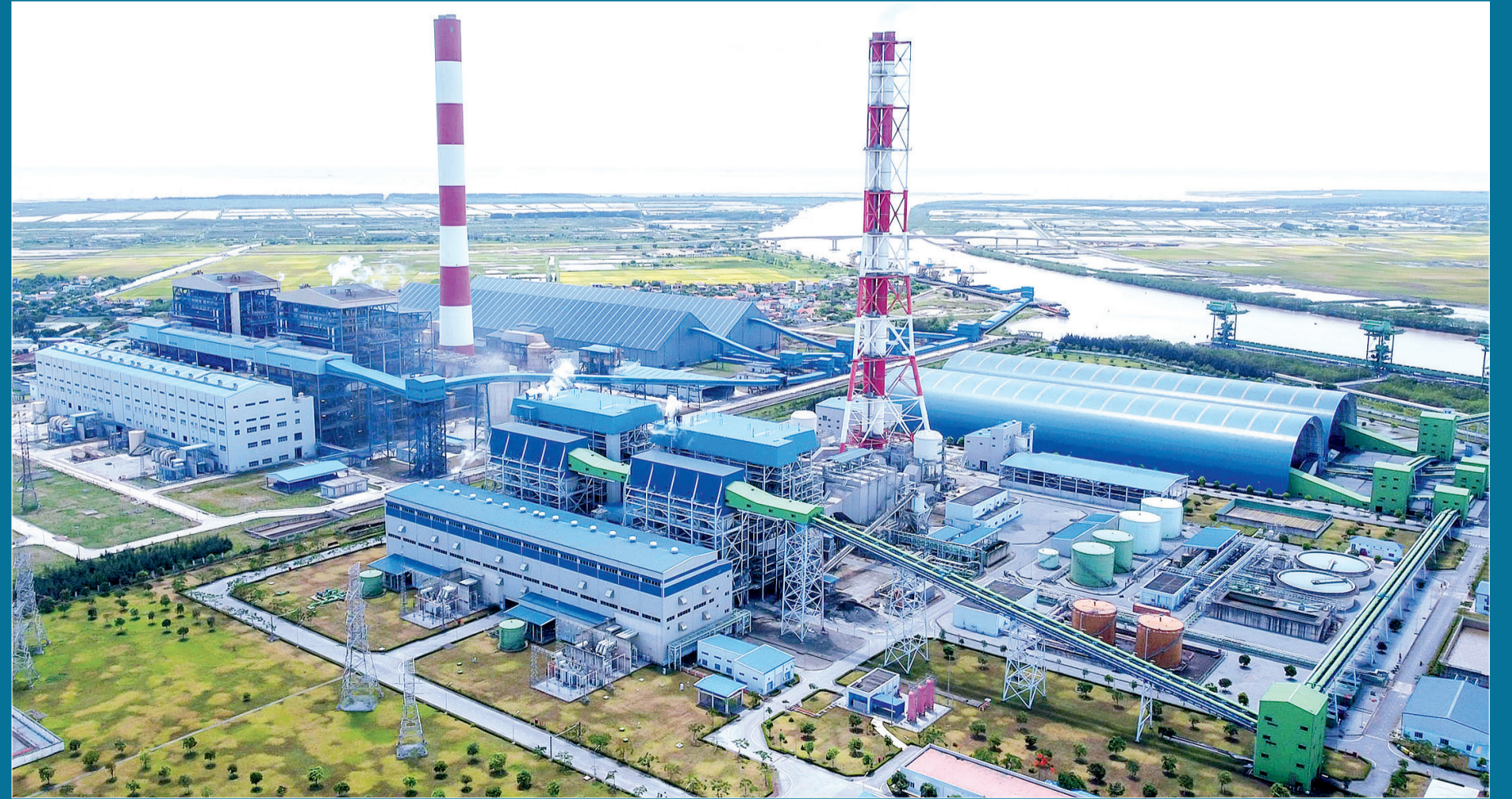
10 tháng năm 2023, giá trị sản xuất, phân phối điện tăng 81,3% so với cùng kỳ năm 2022. Trong ảnh: Trung tâm Điện lực Thái Bình.
