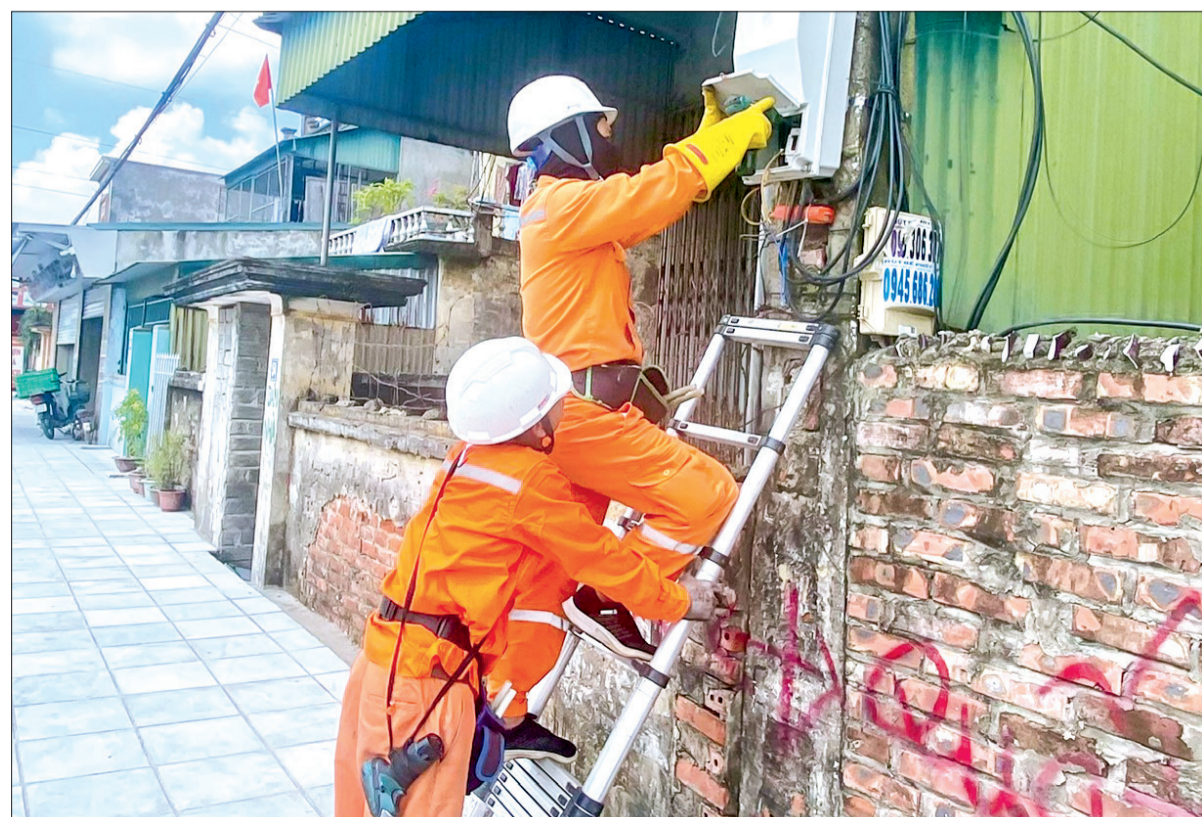
Điện lực Tiên Hải tổ chức thay thế công tơ cơ khí sang công tơ điện tử.
