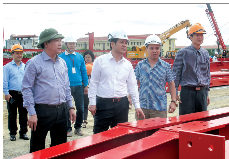
Đồng chí Nguyễn Hồng Diên, Ủy viên Trung ương Đảng, Phó Bí thư Tỉnh ủy, Chủ tịch UBND tỉnh kiểm tra tiến độ thi công nhà máy may công nghệ cao của Công ty Cổ phần Sản xuất hàng thể thao (cụm công nghiệp Vũ Ninh, Kiến Xương).
