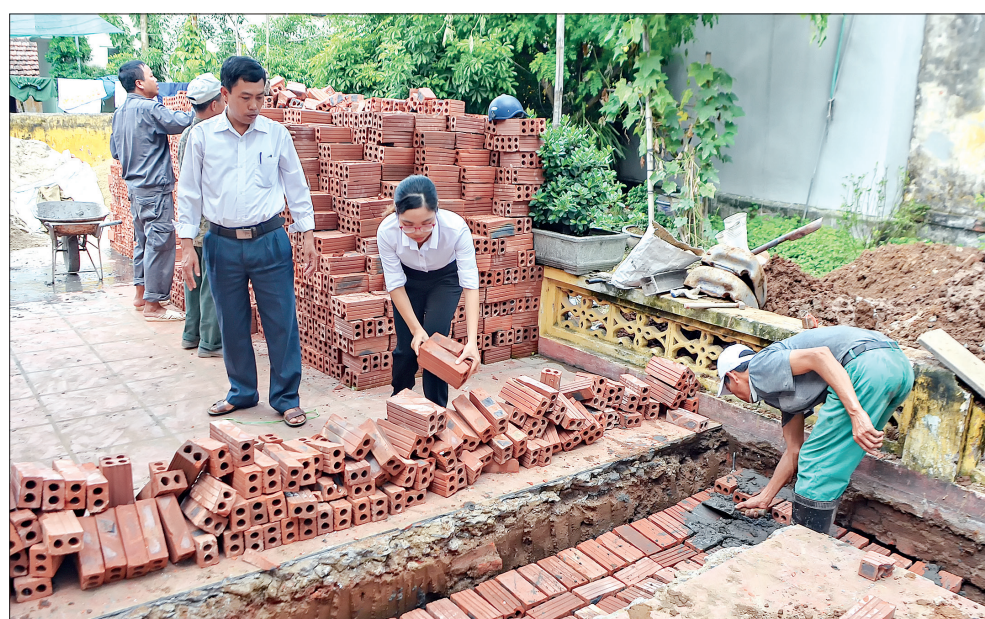
Xây dựng nhà ở cho người có công tại xã Vũ Chính (thành phố Thái Bình).
