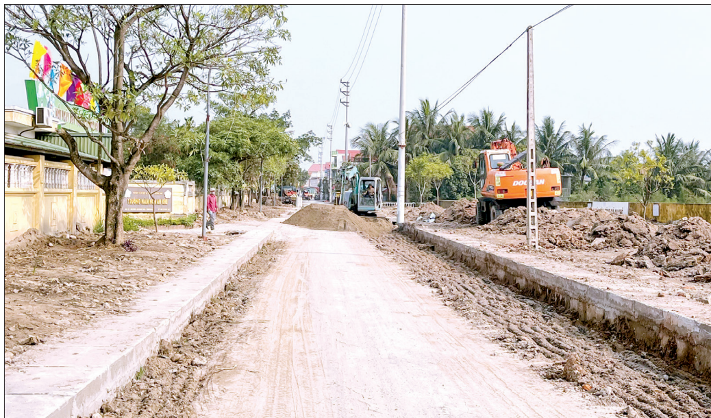
Tuyến đường qua địa bàn thôn Hiệp Lực, xã An Khê, huyện Quỳnh Phụ hiện đang được thi công sau khi 100% các hộ dân đồng thuận hiến đất và di dời tài sản trên đất.
