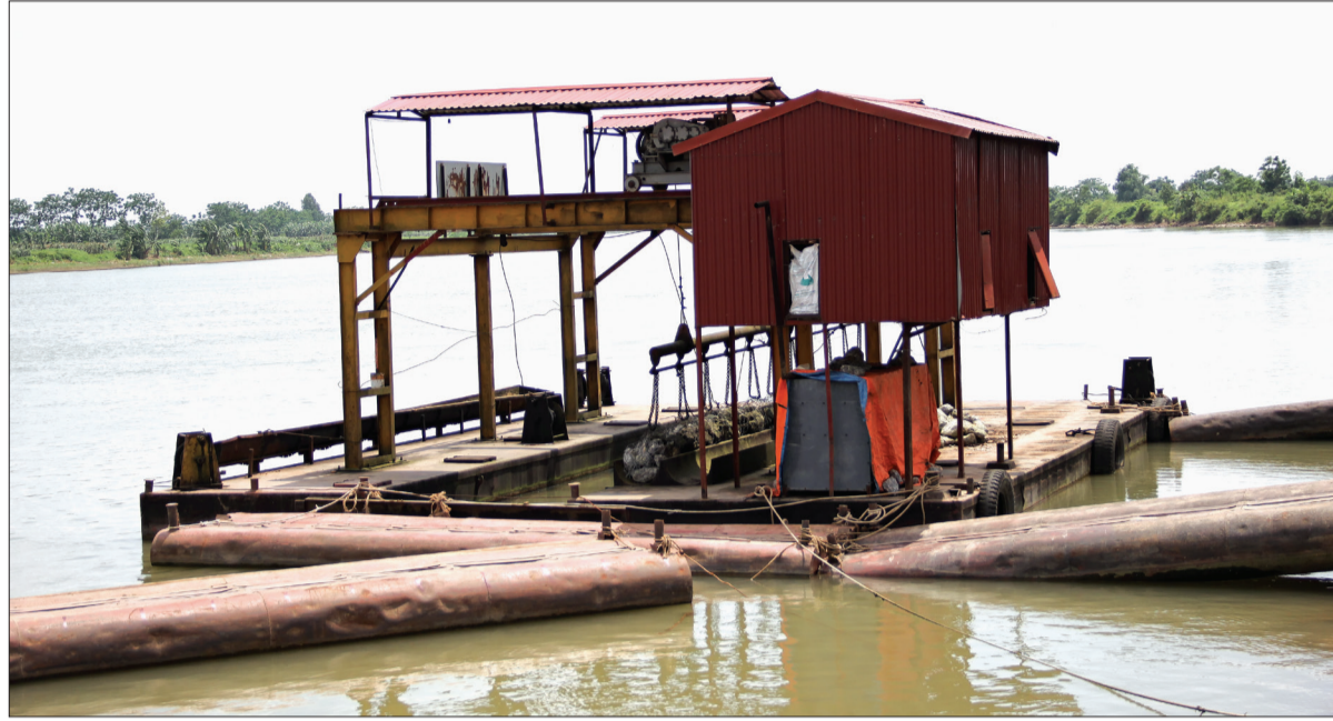
Thi công thả rỗng vỏ thép lõi đã học kè Đại Năm, xã Quỳnh Thọ (Quỳnh Phụ).
