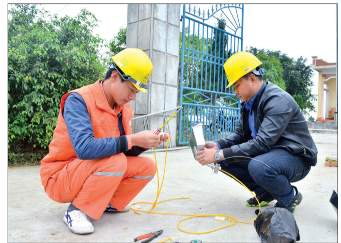
Đoàn viên thanh niên chuẩn bị xây dựng công trình thanh niên thấp sáng đường quê tại thôn Đồng Lâu, xã Vũ An (Kiến Xương).
