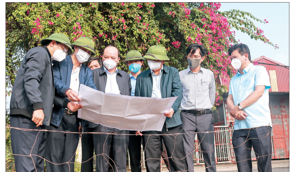
Các đồng chí lãnh đạo tỉnh kiểm tra tiến độ thi công dự án cải tạo, nâng cấp tuyến đường tỉnh ĐT.452 (đường 224 cũ), đoạn từ ngã tư La đến đường nối hai tỉnh Thái Bình - Hà Nam.
