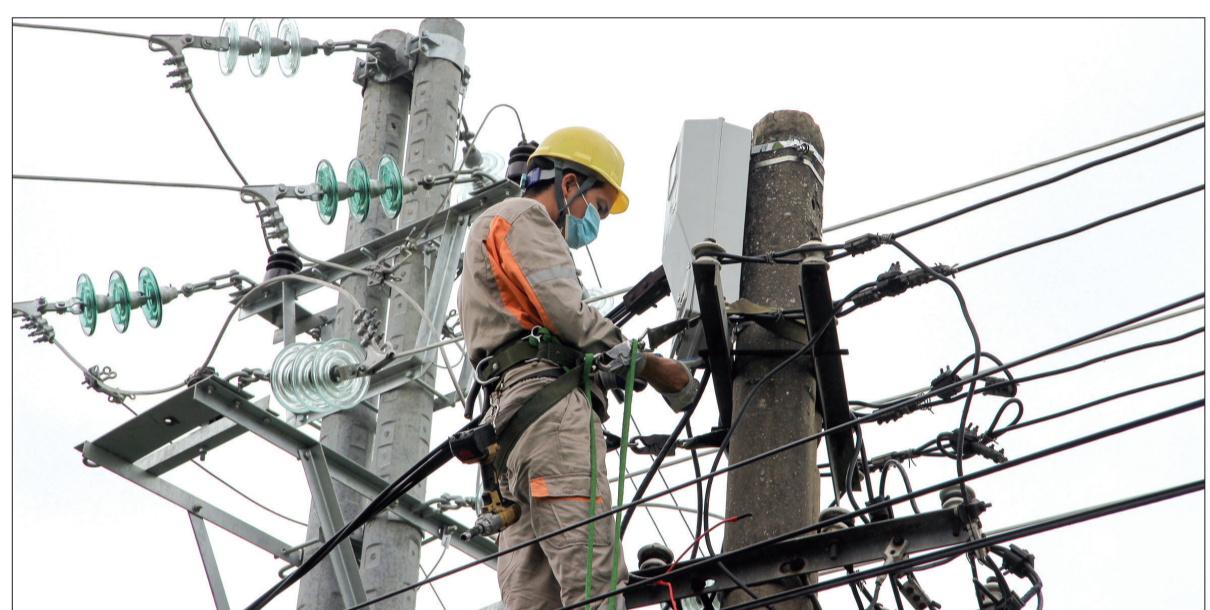
Điện lực Kiến Xương nâng cấp hệ thống truyền tải điện bảo đảm cấp điện ổn định, an toàn.
