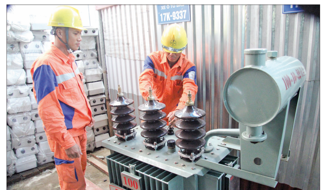
Công nhân Điện lực Đông Hưng kiểm tra máy biến áp trước khi lắp đặt.
