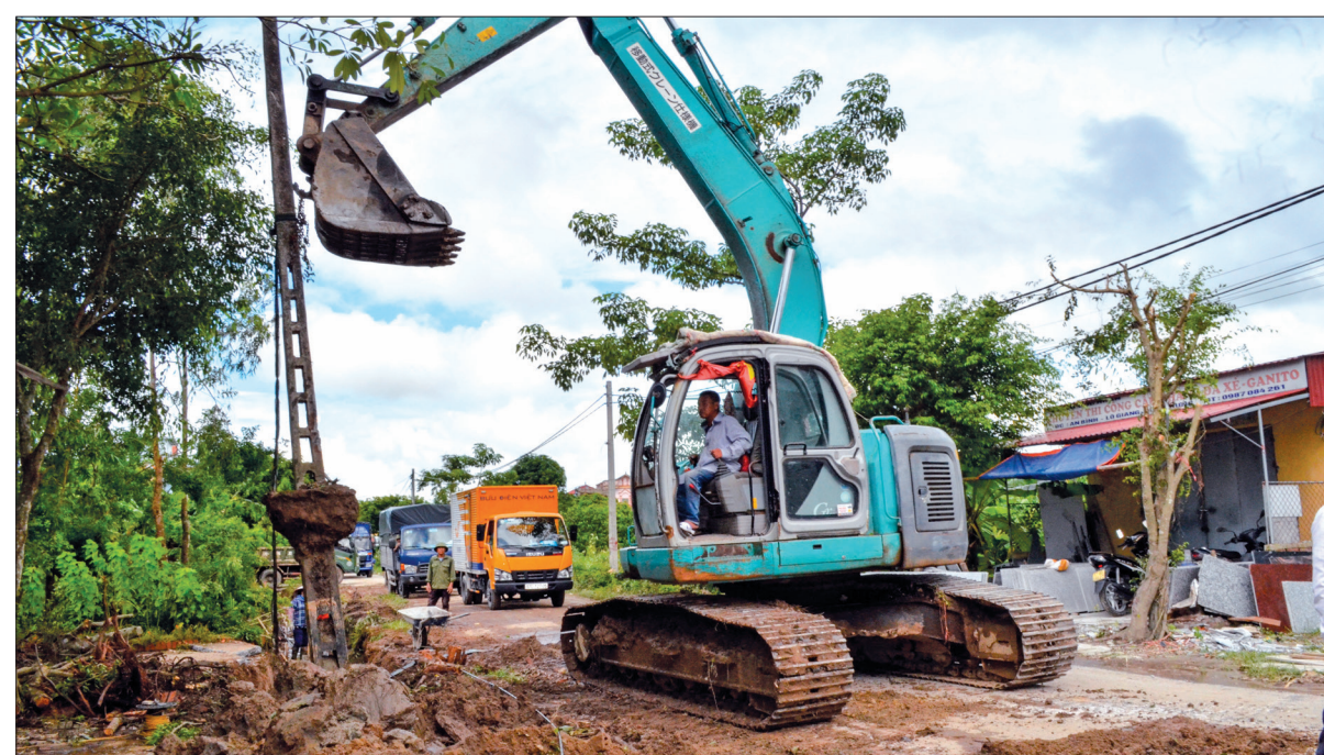
Người dân xã Lô Giang (Đông Hưng) bàn giao mặt bằng phục vụ thi công cải tạo đường ĐH45.
