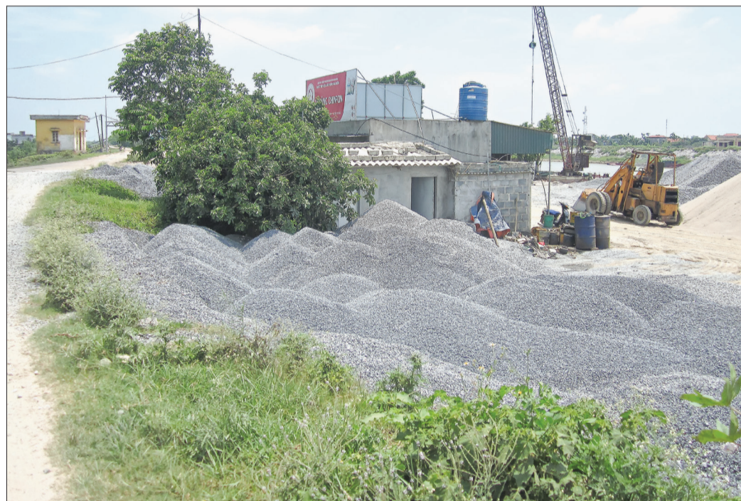
Vật liệu xây dựng tập kết vì phạm hành lang bảo vệ an toàn đê điều.
