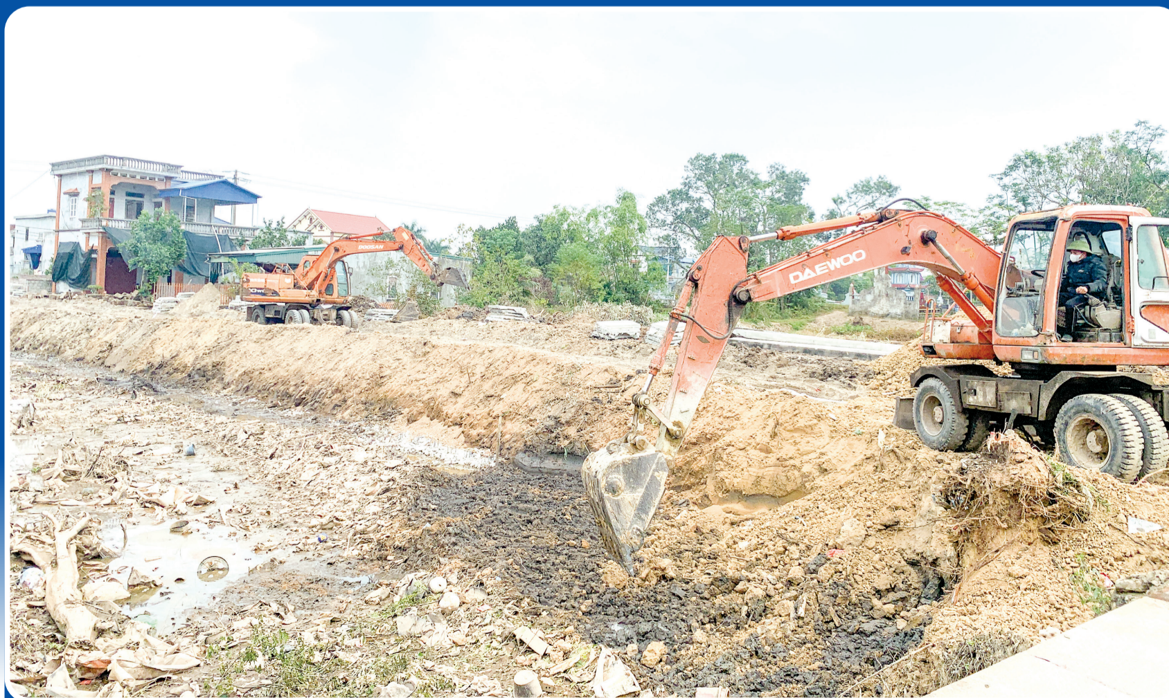
Thi công dự án nạo vét và kè kênh 223 huyện Hưng Hà.
