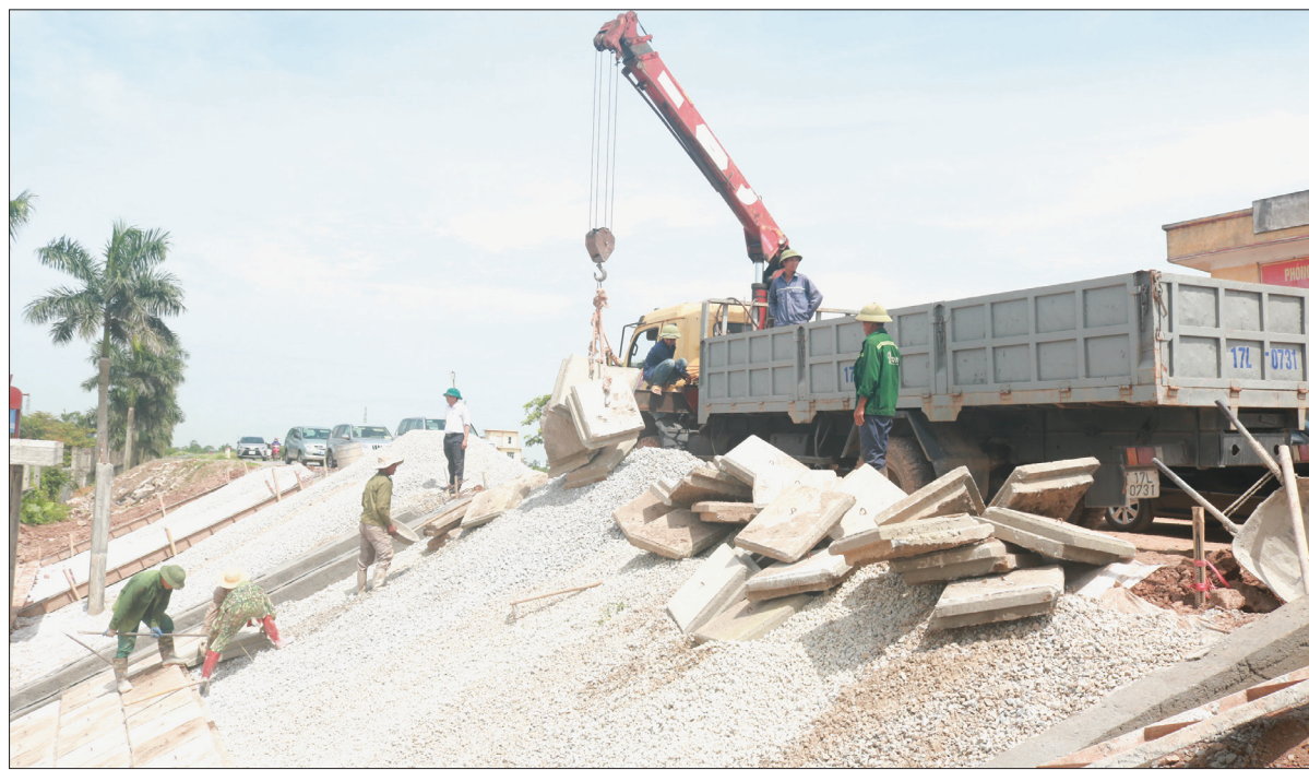
Thi công cống Đổng Bàn, xã Trọng Quan (Đông Hưng).
