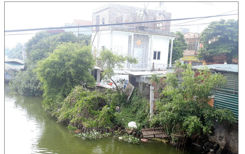
Sông Kiến Giang đoạn qua địa phận xã Bình Minh bị các hộ dân lấn chiếm từ nhiều năm nay.
