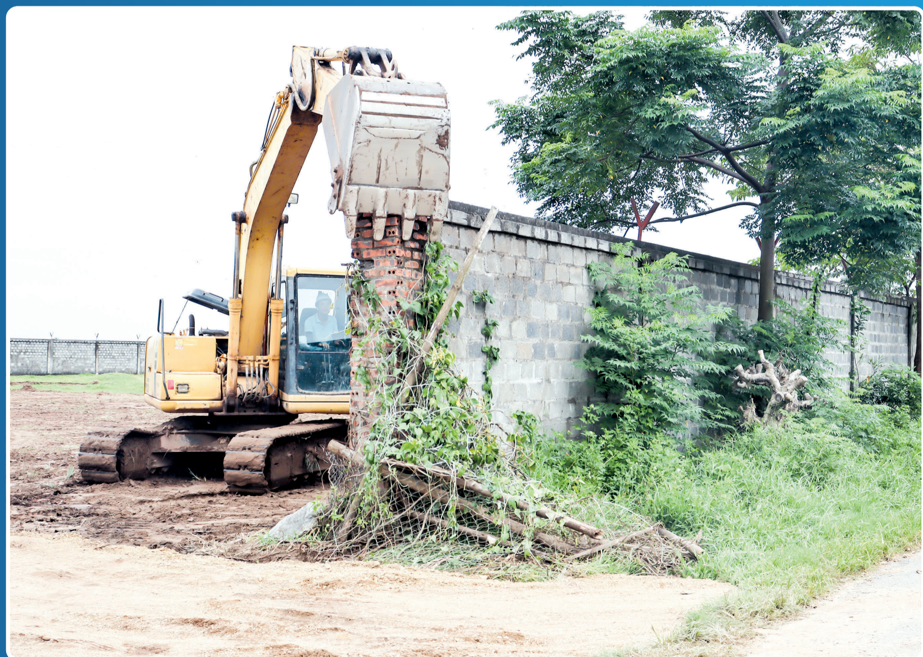
Giải phóng mặt bằng dự án cải tạo, nâng cấp đường Bình Định - Hồng Tiến (Kiến Xương).
