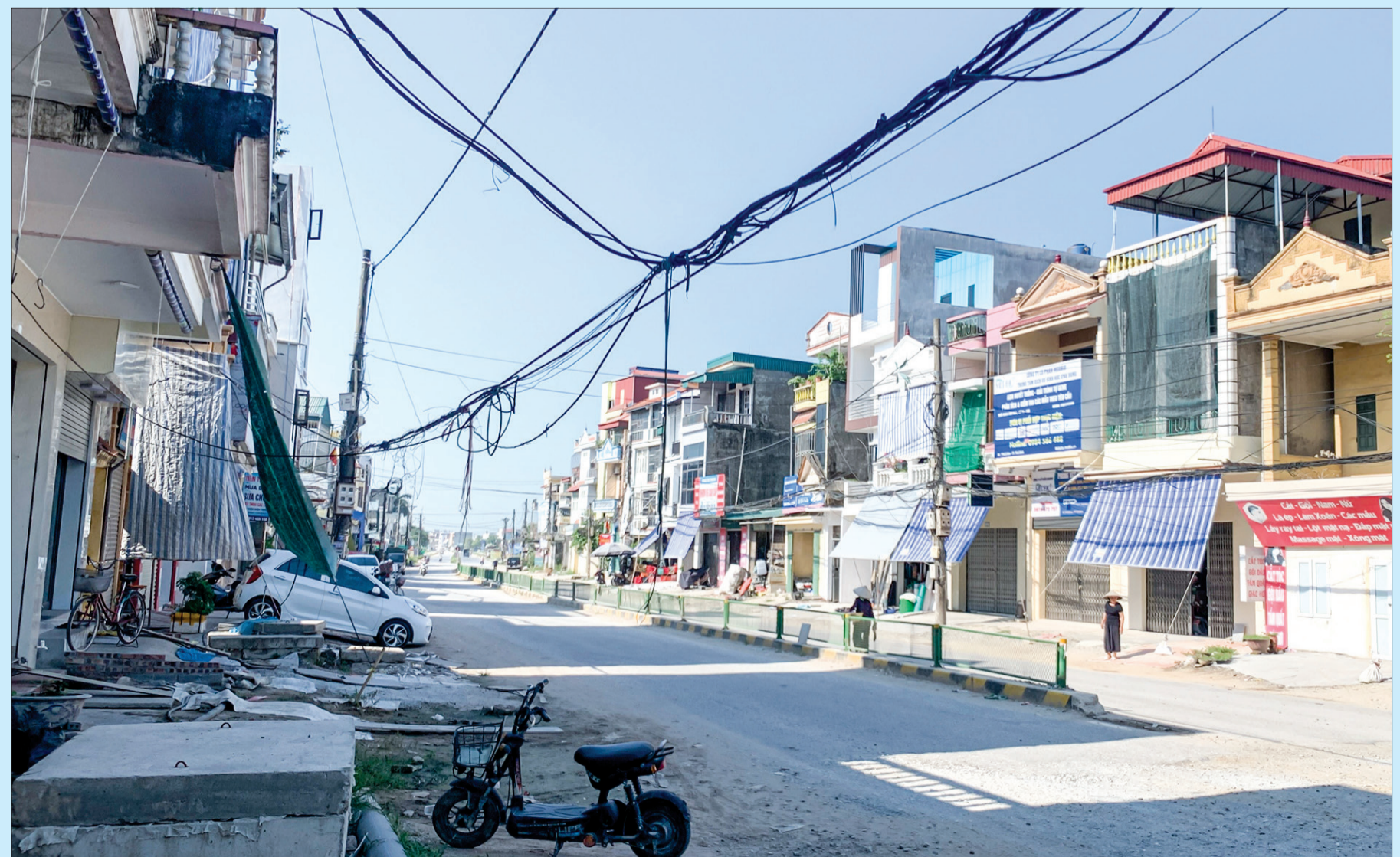
Dự án nâng cấp cải tạo đường tỉnh 454, đoạn từ thành phố Thái Bình đến cầu Sa Cao có nguy cơ chậm tiến độ vì hạ tầng lưới điện.
