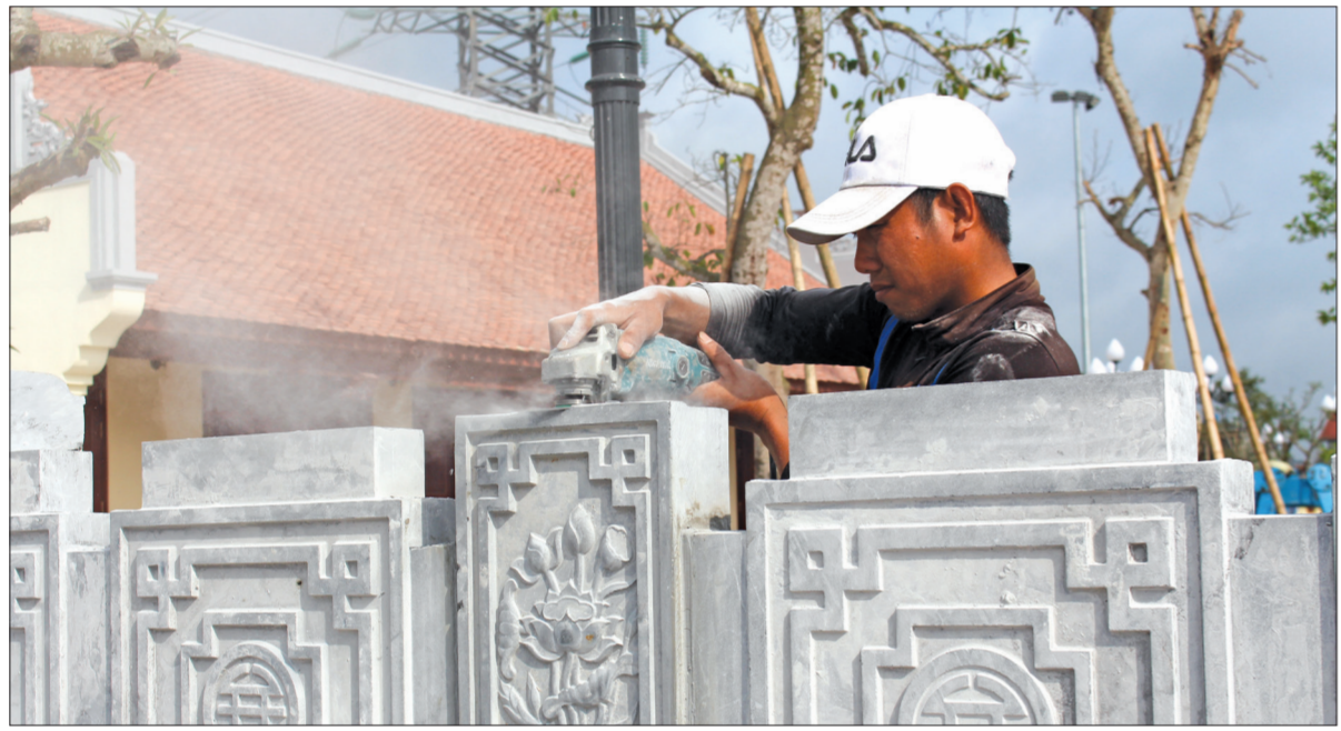
Thi công hoàn thiện tường rào bao quanh Đền thờ.
