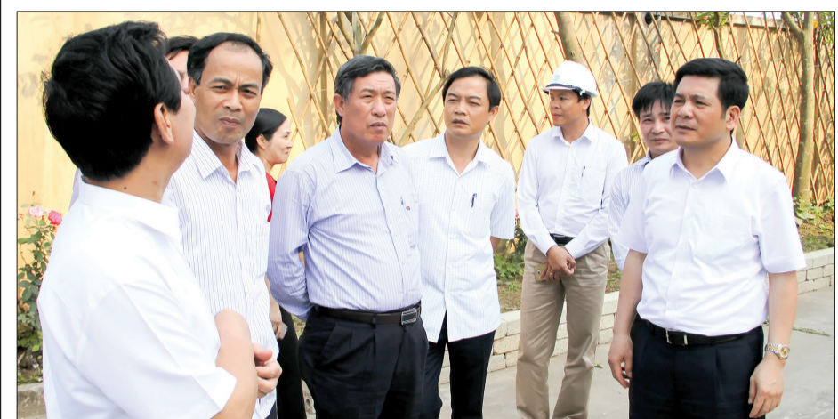
Đồng chí Nguyễn Hồng Diên, Ủy viên Trung ương Đảng, Phó Bí thư Tỉnh ủy, Chủ tịch UBND tỉnh kiểm tra, chỉ đạo công tác giải phóng mặt bằng tại nút giao quốc lộ 39 đoạn qua địa phận thị trấn Hưng Hà (Hưng Hà).
