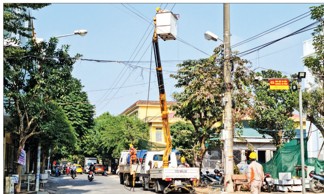
Nâng cấp lưới điện trên địa bàn phường Kỳ Bá (thành phố Thái Bình).
