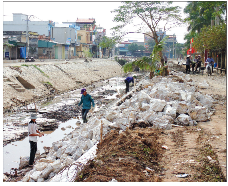
Triển khai làm kê hai bên bờ sông thuộc dự án đường ĐH07.
