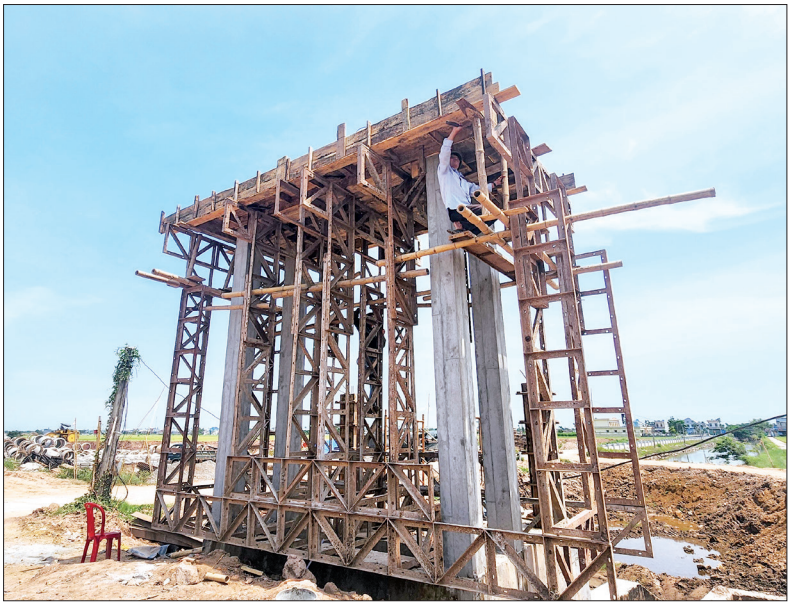
Thi công công tác dự án xử lý cấp bách tuyến đê I.
