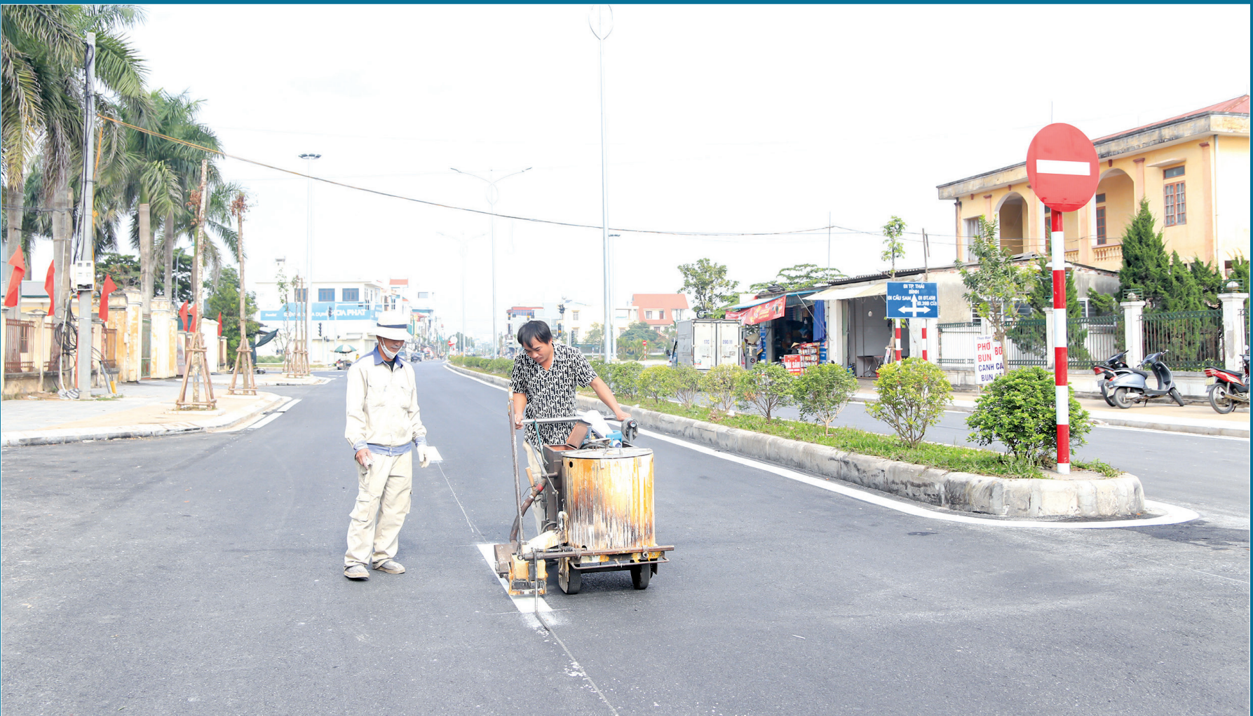
Thi công hoàn thiện hệ thống vạch kẻ đường tuyến đường tỉnh 454 (đường 223 cũ) đoạn từ thành phố Thái Bình đến cầu Sa Cao.
