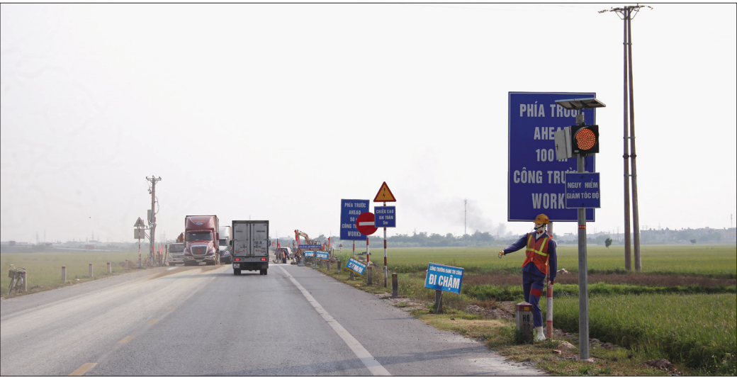
Nhà thầu thi công lắp đặt các biển báo hiệu, cọc tiêu để bảo đảm an toàn cho người tham gia giao thông.
