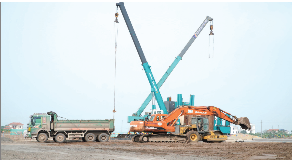
Nhà thầu huy động tối đa nhân lực, phương tiện thi công dự án nhà máy Good Way Việt Nam.
