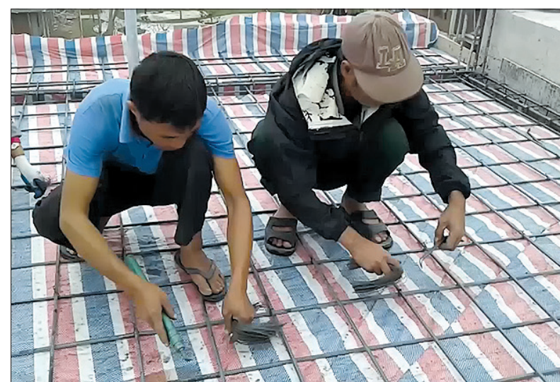
Dụng cụ buộc đai sắt bán tự động được thử nghiệm tại các công trình xây dựng trên địa bàn thành phố Thái Bình.
