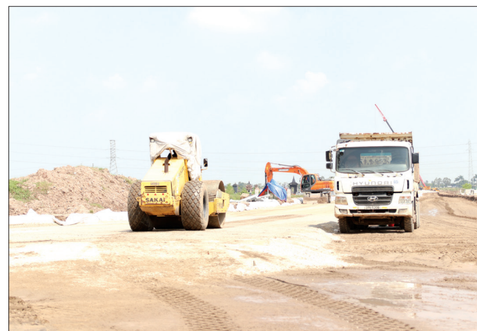
Thi công tuyến đường bộ ven biển tại nút giao quốc lộ 39, địa phận thị trấn Diêm Điền (Thái Thụy).
