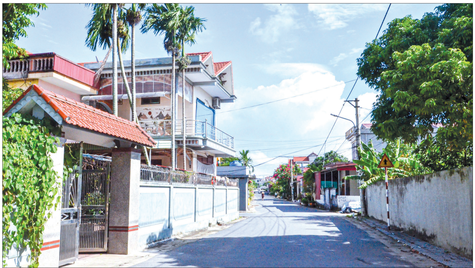
Hệ thống đường giao thông, điện chiếu sáng trên địa bàn thị trấn Diêm Điền được đầu tư xây dựng đồng bộ.
