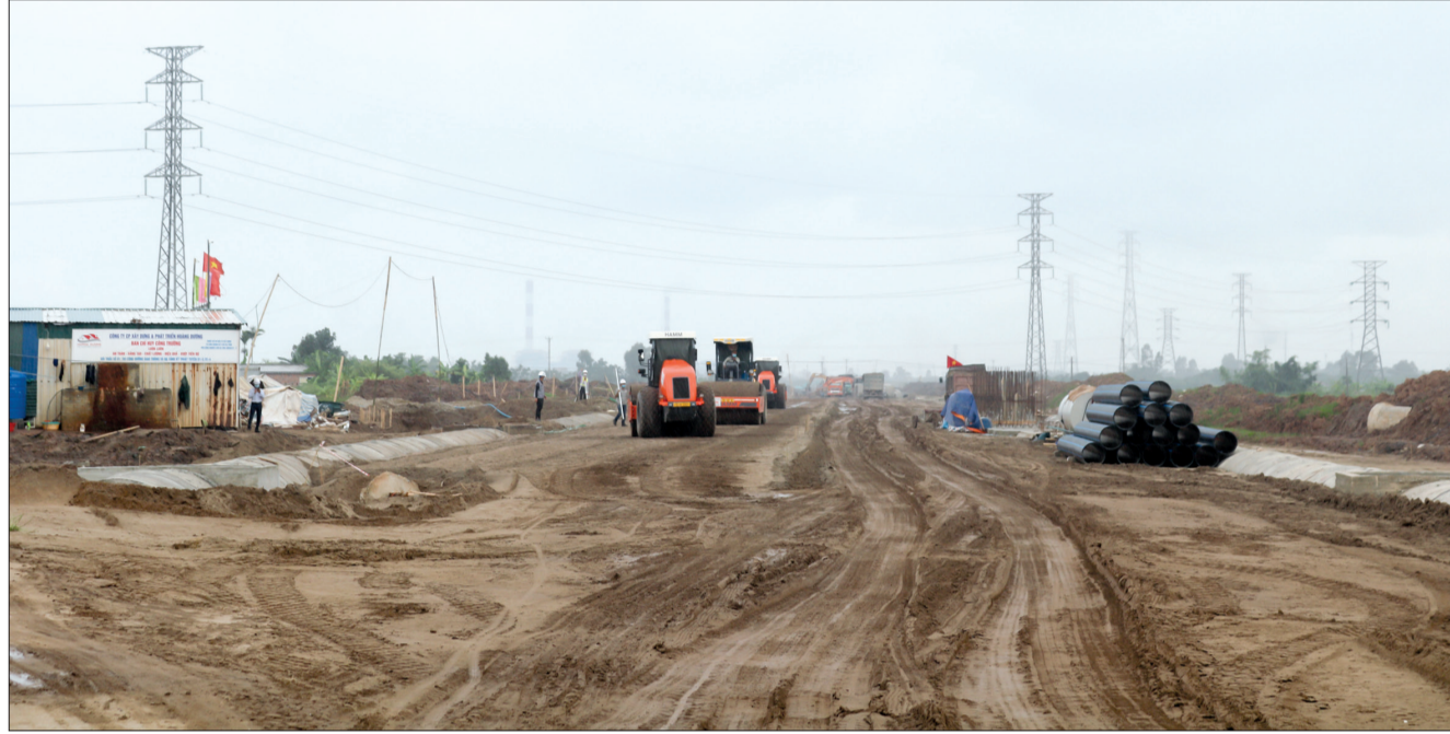
Thi công đường giao thông và hạ tầng kỹ thuật khu công nghiệp Liên Hà Thái.
