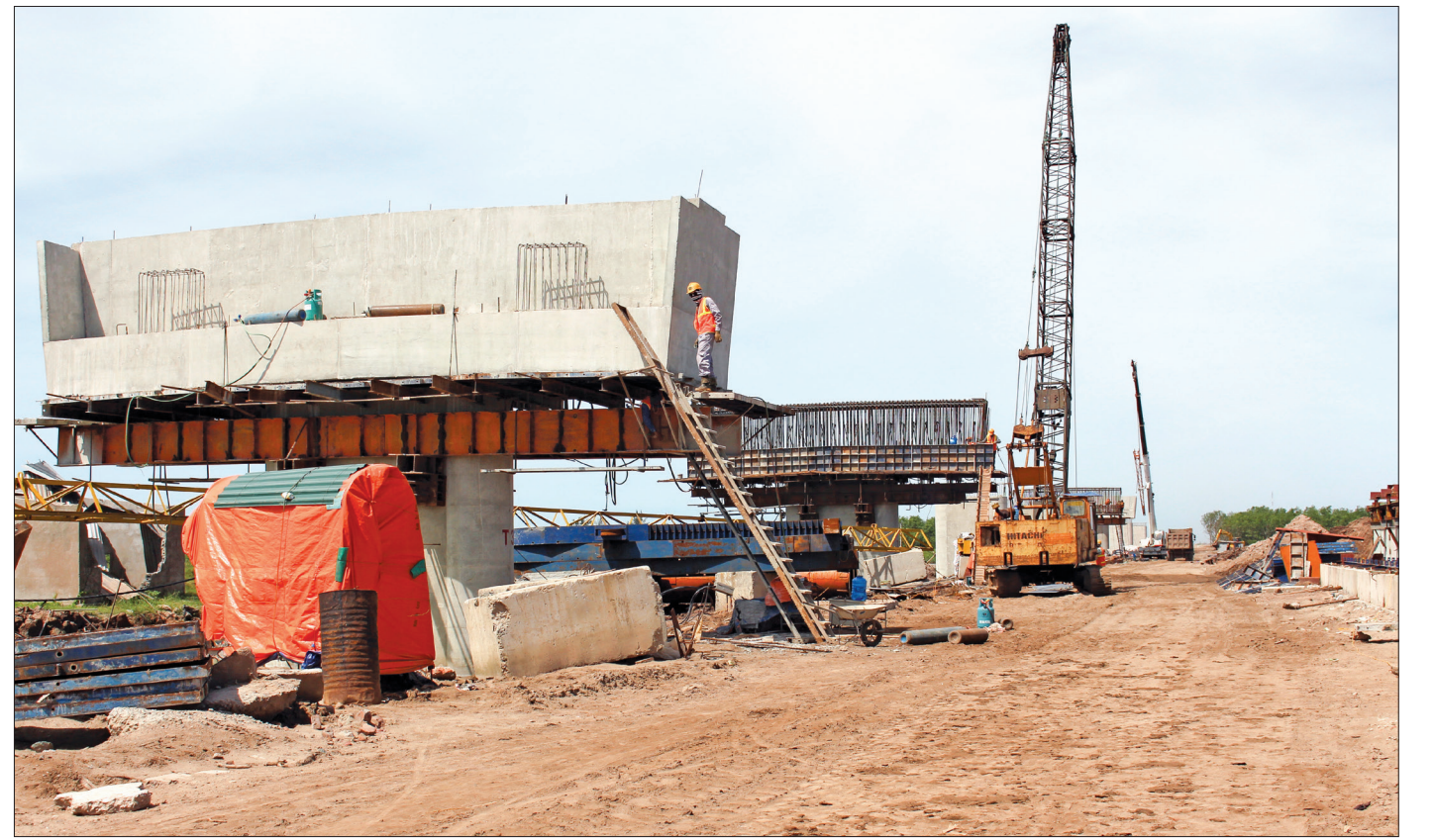
Thi công công trình cầu sông Hồng.
