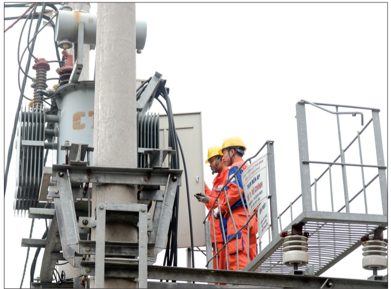
Kiểm tra trạm biến áp để kịp thời bảo dưỡng, giữ ổn định nguồn điện.
